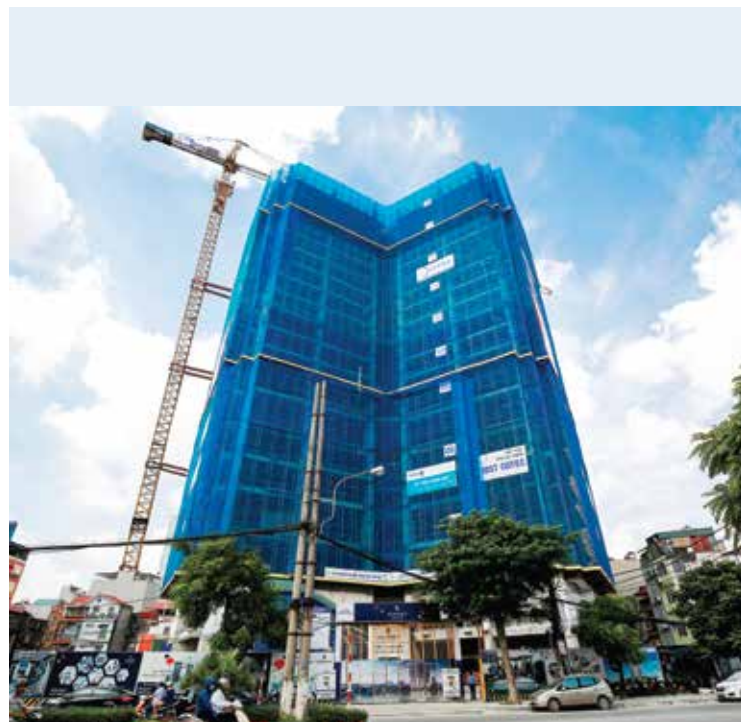
Lưới bao che công trình để bao che, chắn bụi, bảo vệ an toàn cho các công trình, đặc biệt là các công trình cao tầng.
