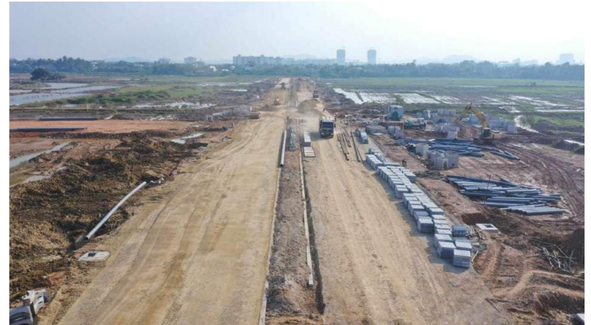
Là một trong 3 tuyến đường huyết mạch của khu đô thị, đường trung tâm 2 với chiều dài 509m cơ bản hoàn tất việc đắp đất K95, K98, lắp đặt các hố ga thoát nước mưa theo kế hoạch và đang trong quá trình thi công cống nước thải.
